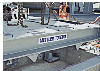
Весовая платформа вагонных весов состоит из прочных грузоприемных модулей, устанавливаемых в приямок. Модульная конструкция вагонных весов обеспечивает простоту монтажа весов без применения сварочных работ. Модули имеют возможность расширяться и сжиматься при изменении температуры и приложенной нагрузки. При обслуживании вагонных весов доступ ко всем компонентам осуществляется через сдвигаемые панели.
